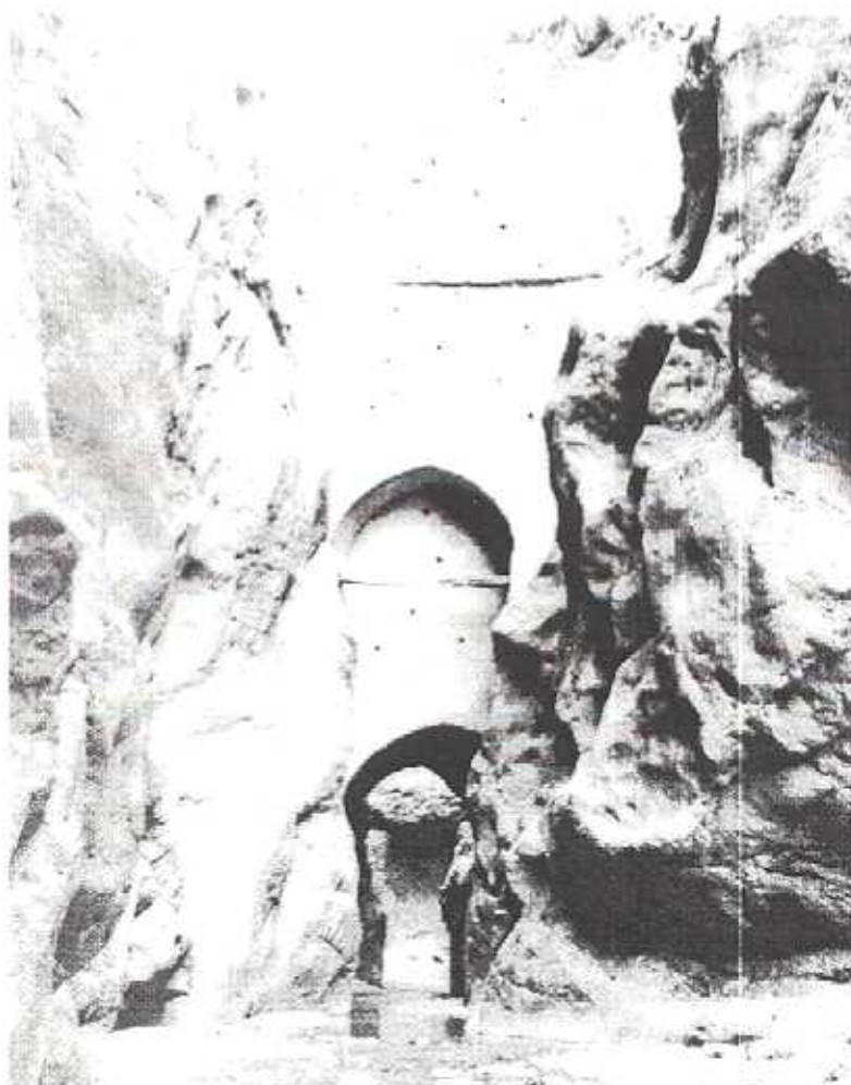
شکل (۲) : سد عباسی در ۲۵ کیلومتری شمال شرقی طیس با سیستم انحراف مشابه سد کریت
